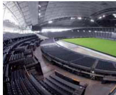
2010年度の主な計画修繕・設備更新
