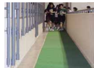
●滝川市スポーツセンター 施設内のランニングコースに敷き詰め、ご利用いただいています。従来はコンクリート床で固かったものが、人工芝によってクッション性が生まれ、ランニングなどで体にかかる負担が軽減されました。
