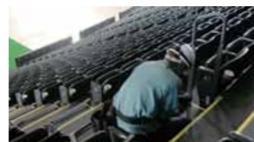
可動席の階段に手すりを設置。知恵を出し合い、折り畳めるタイプにすることで技術的な問題をクリアしました。
