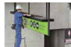
● 1階コンコース大階段大型サイン看板除塵清掃
