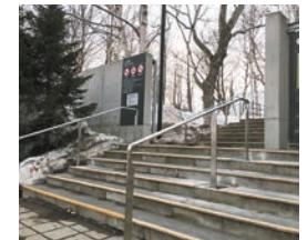
■バス停口階段 敷地内への出入口（バス停口）にある階段に手すりを新たに設置。
