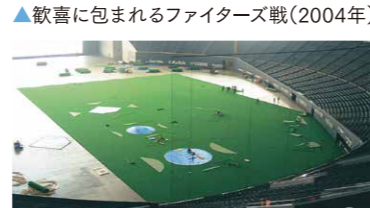
▲人工芝の張り替え工事(2005年)
