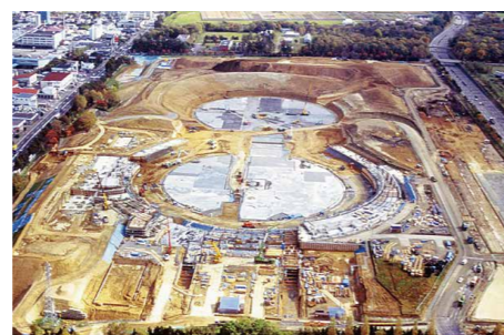
▲札幌ドームの輪郭が現れ始めた頃(1998年)
