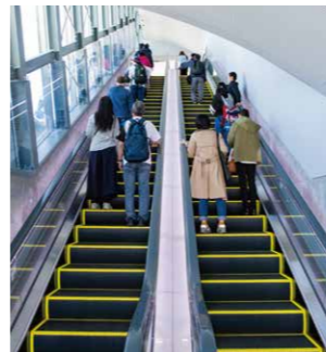
▲屋外エスカレーターを設置(2019年)
