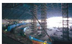
▲アリーナ内観の工事(2000年)
