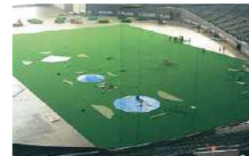
開業以来初の人工芝張り替え工事(2005年)
