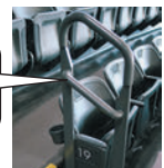
増設する手すり
